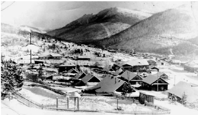
Зимой посёлок Согдиондон утопал в снегу по крыши...
