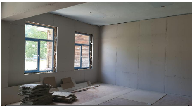
Заместитель губернатора отметил отличный уровень проведения ремонтных работ в школе в п. Луговский. Напомним, что подрядчиком по проведению капитального ремонта Луговской школы выступила местный индивидуальный предприниматель Елена Сапрыкина
