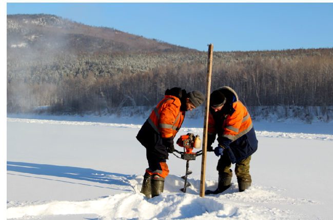
Дорожники филиала «Бодайбинский» ОАО «ДСНО» делают промеры толщины льда на ледовой переправе Мусковит-Мамакан
