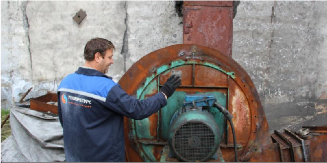
Оба дымососа - левый и правый исправны, - говорит мастер Алексей Кочко и затем поясняет для журналиста. - Дымосос ДМ 11-2 имеет 1000 оборотов. Мы разбираем, проверяем подшипники, сушим, смотрим, полностью разбираем мотор, меняем колеса. Колеса сгорают так, что буквально вздуваются и вылетают, так рвёт металл. Сейчас всё исправно, - заверяет мастер
