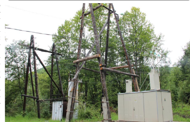
В поселке Витимский проведена полная реконструкция электрических сетей: установлены 90 новых опор, смонтированы две новые комплектные трансформаторные подстанции (КТПН)
