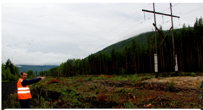
Реконструкция ведётся с расчисткой просек и установкой листовидных опор с железобетонными насытками. Опоры, в зависимости от грунта вкапываются в землю от 2-х до 2,5 метров на расстоянии от 150 до 200 метров
